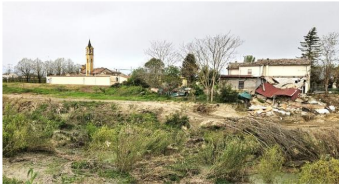
La situazione degli argini lungo il fiume Ronco
